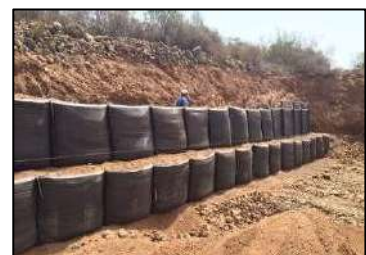
Muros de gravedad gaviones flexibles
